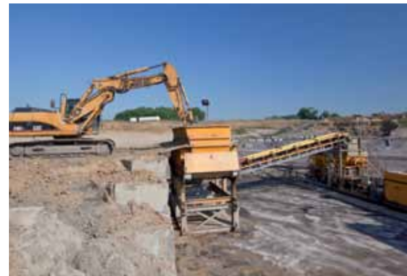
Sagrex Tellier-des-Prés - vloeibare modder wordt ondergronds over een afstand van 1,5 km vervoerd.
